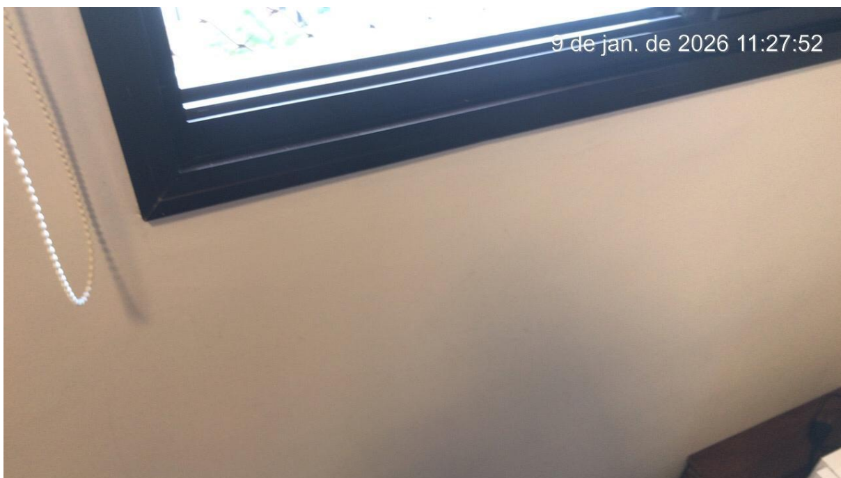
Figura 12 - Parede não apresenta sinais de umidade provenientes da fachada
