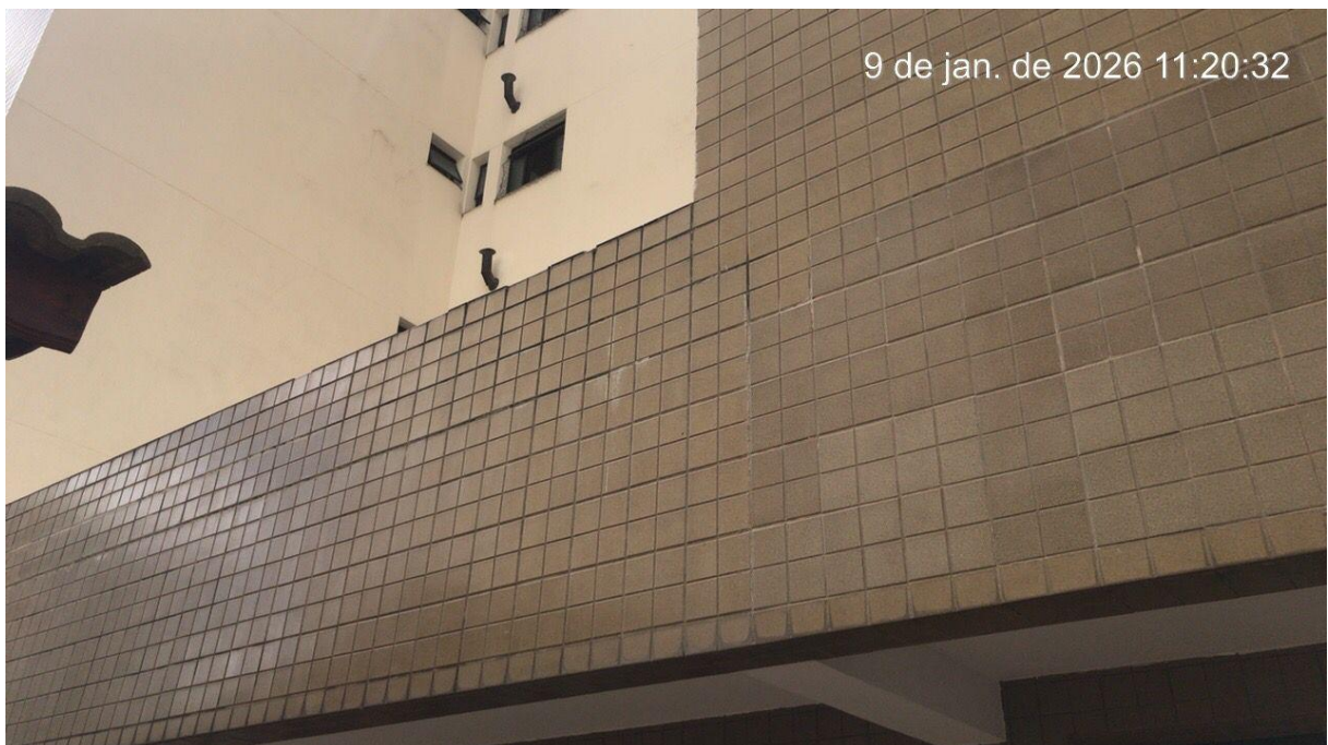
Figura 5 - Parede externa do edifício revestida com azulejo
