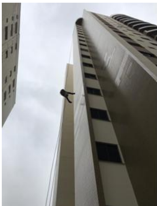
Figura 44-“Cordista” ou Alpinista Predial executando aspersão dirigida de água com fluxo contínuo
