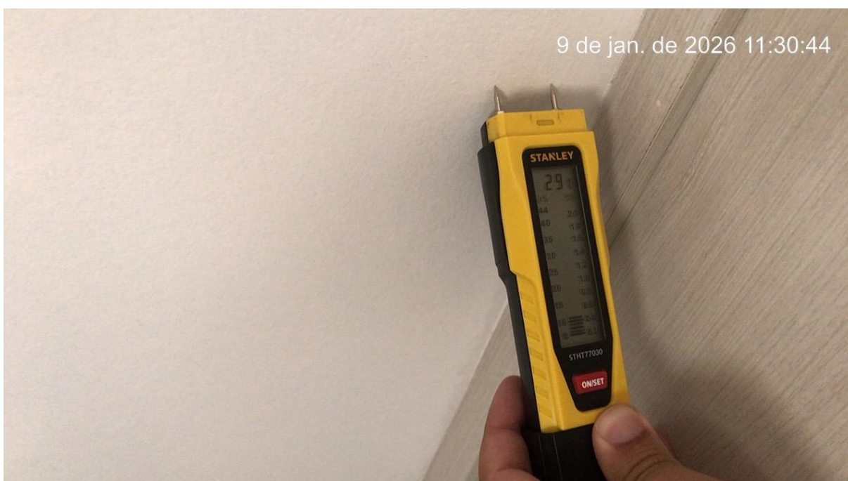
Figura 18 - Parede não apresenta sinais de umidade provenientes da fachada
