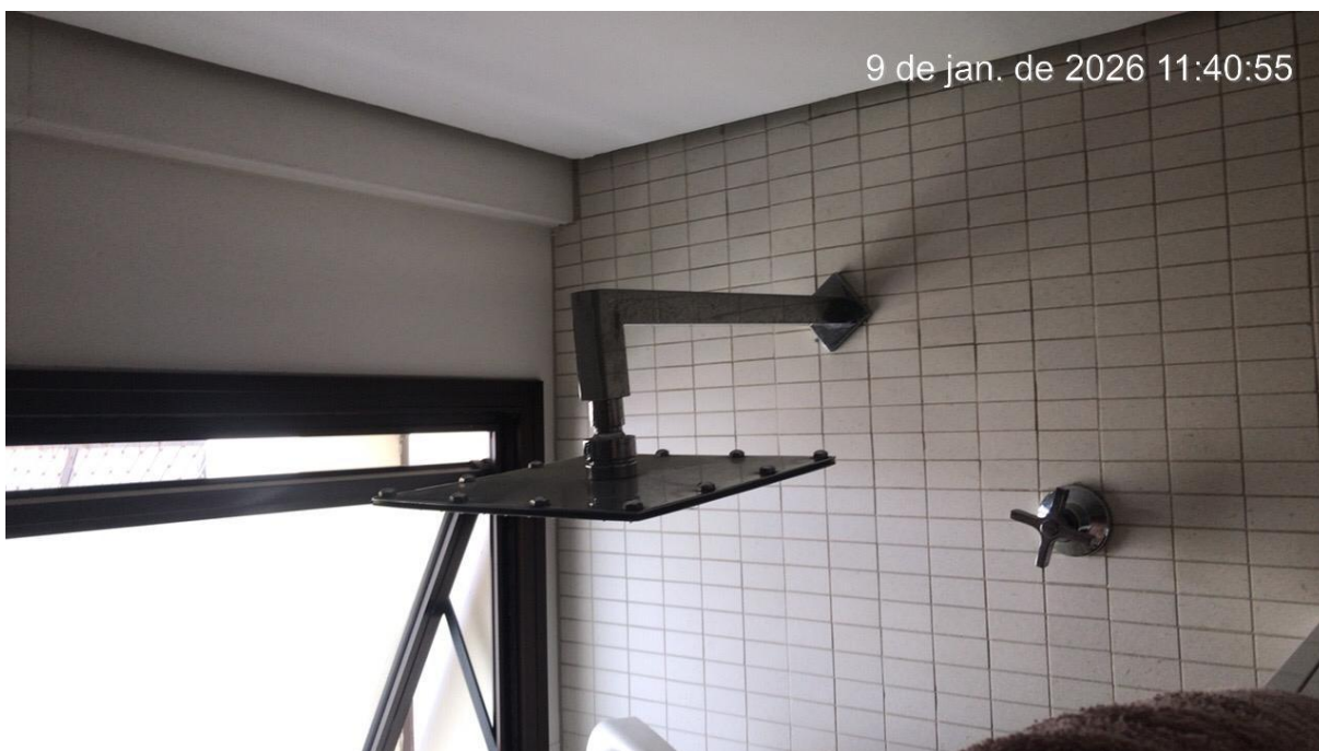
Figura 38 - Não foram identificados indícios de infiltração no local
