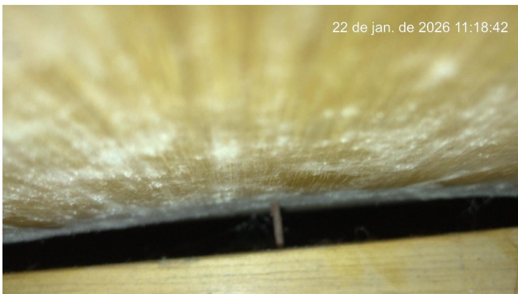
Figura 60-Não apresentou sinais de umidade/infiltração recente
