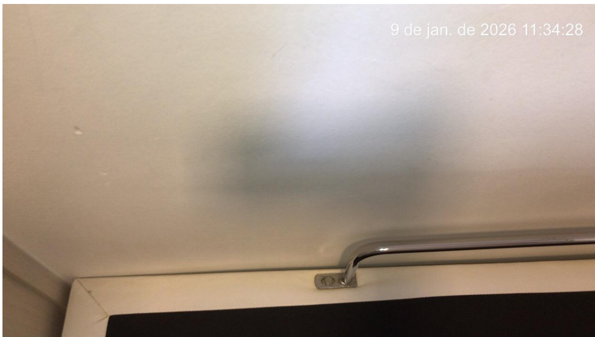
Figura 29 - Parede não apresenta sinais de umidade provenientes da fachada
