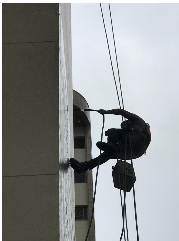
Figura 45-Alpinista Predial executando aspersão dirigida de água com fluxo contínuo
