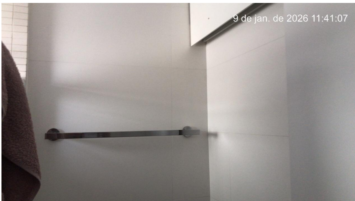
Figura 36 - Não foram identificados indícios de infiltração no local
