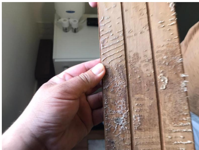
Figura 42 - Apresentam aspecto visual seco sem indícios de umidade antiga
