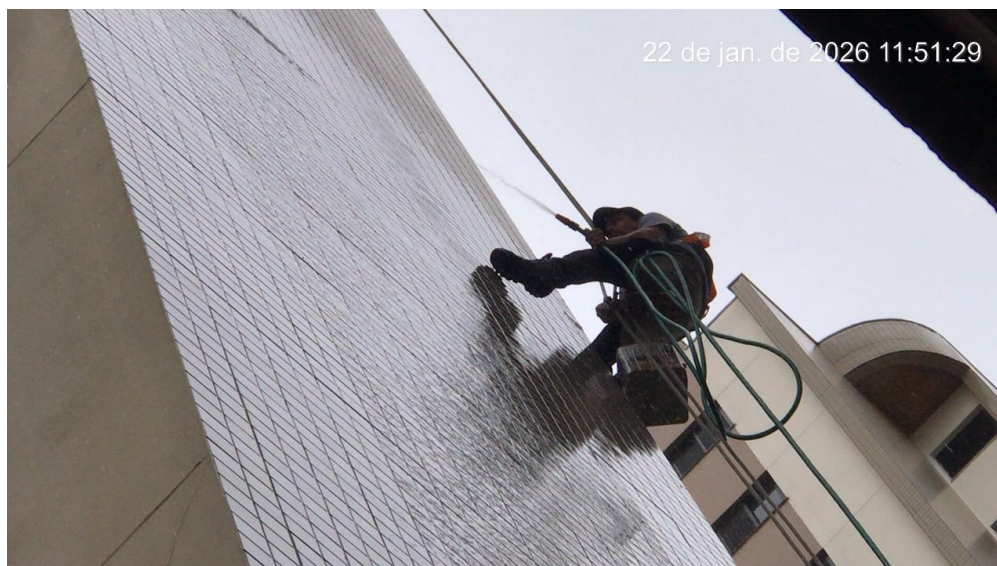
Figura 66-Alpinista Predial executando aspersão dirigida de água com fluxo contínuo
