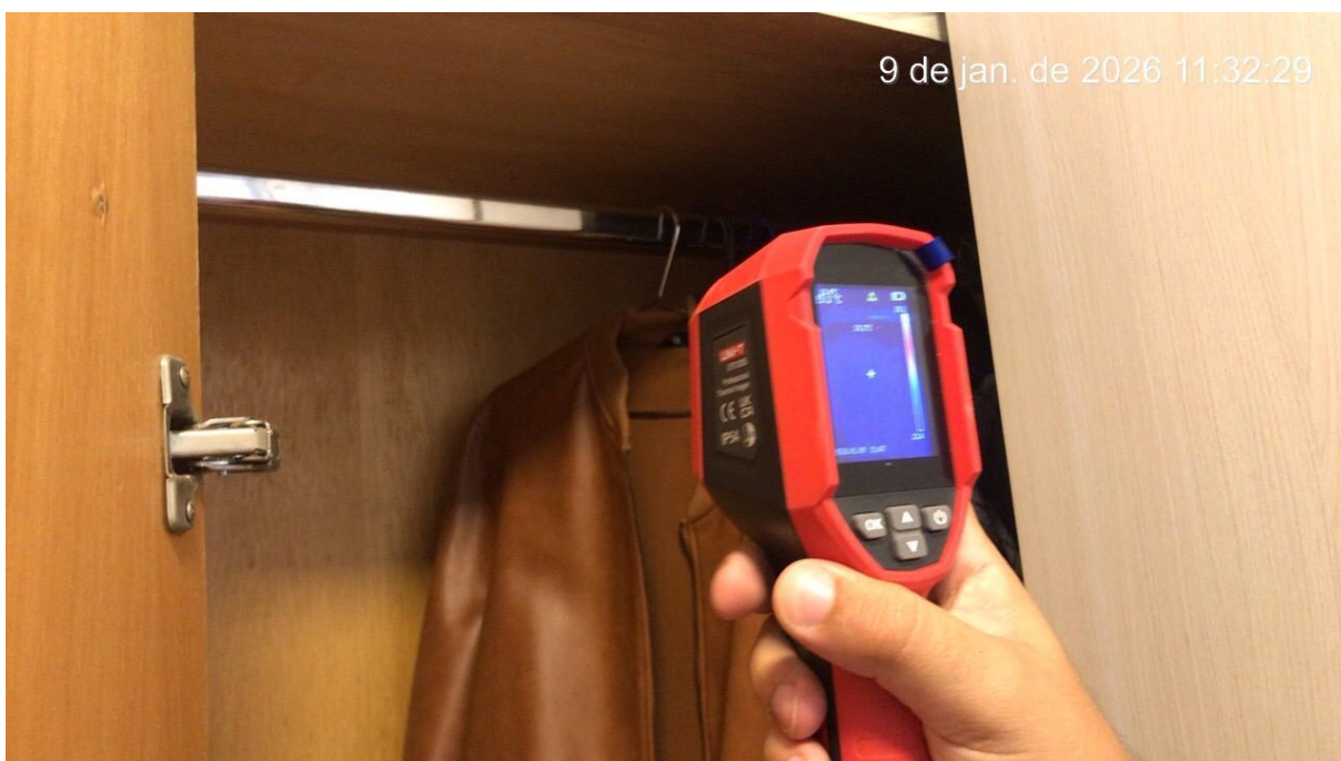
Figura 26 - A câmera termal não identificou sinais de umidade provenientes da fachada
