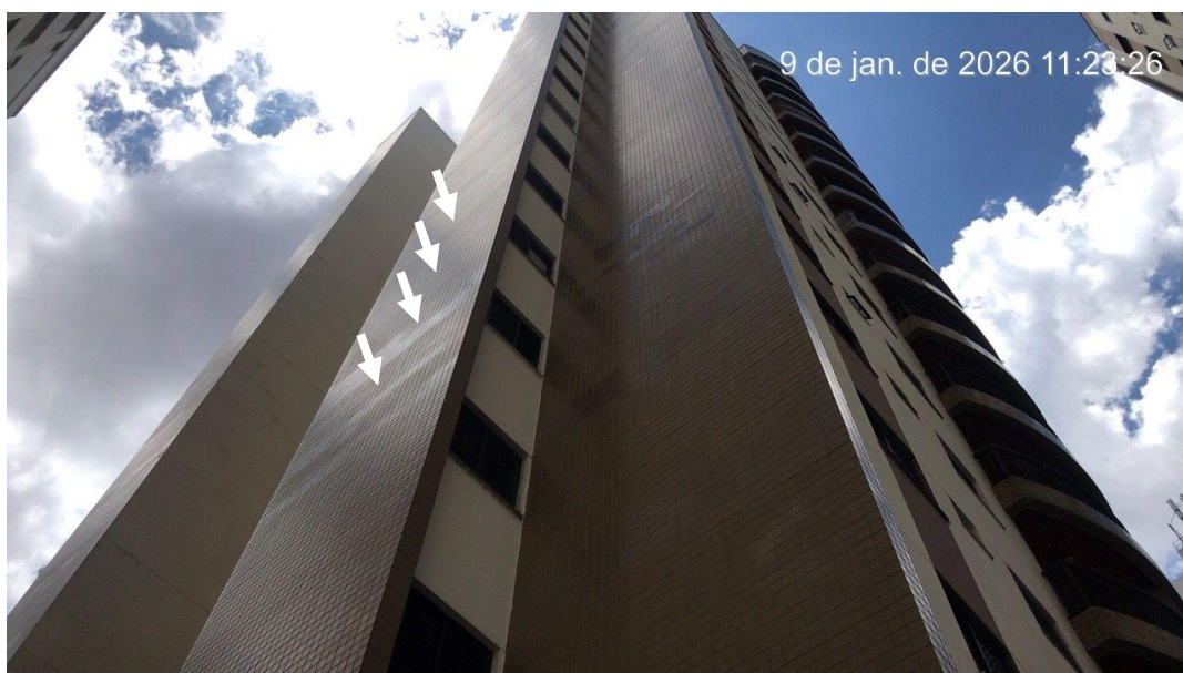
Figura 3 – Fachada a ser inspecionada
