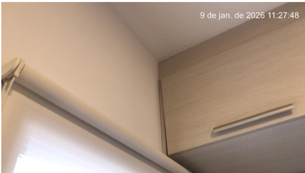
Figura 15 - Armário não apresenta sinais de umidade provenientes da fachada
