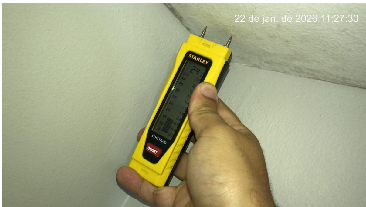
Figura 64-Não apresentou sinais de umidade/infiltração
