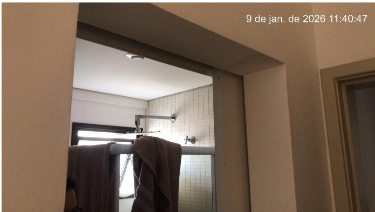
Figura 33 - Não foram identificados indícios de infiltração no local
