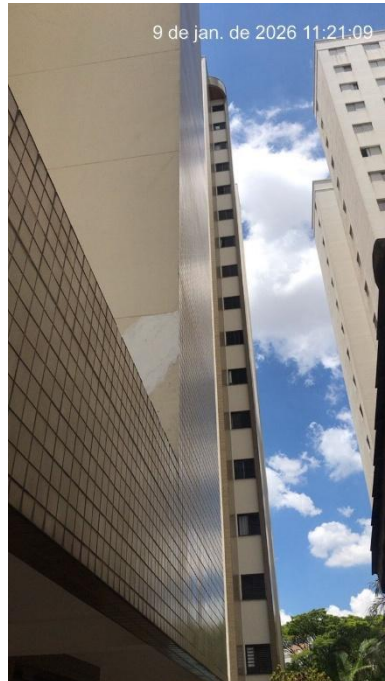
Figura 4 - Lateral do edifício
