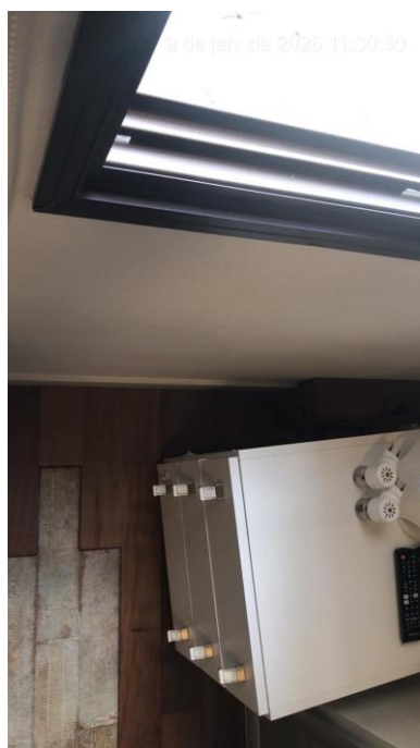
Figura 14 - Parede não apresenta sinais de umidade provenientes da fachada
