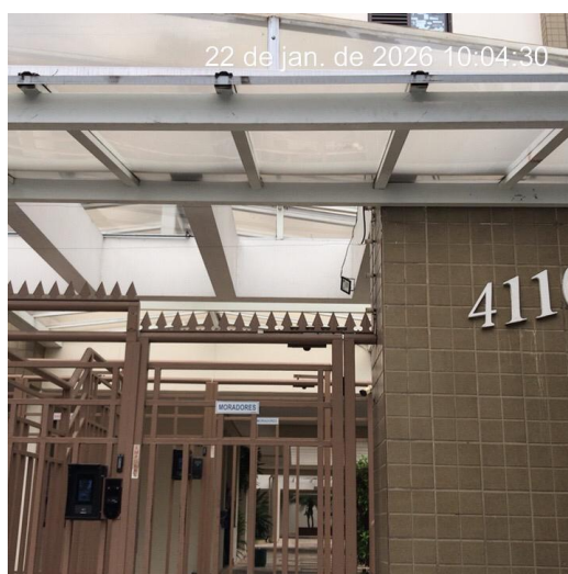
Figura 43 - Portão de acesso com cobertura
