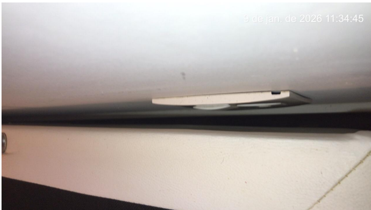
Figura 31 - Parede não apresenta sinais de umidade provenientes da fachada
