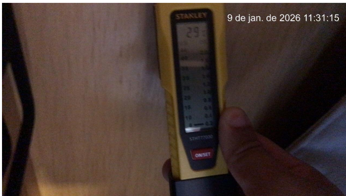
Figura 20 - Armário não apresenta sinais de umidade provenientes da fachada
