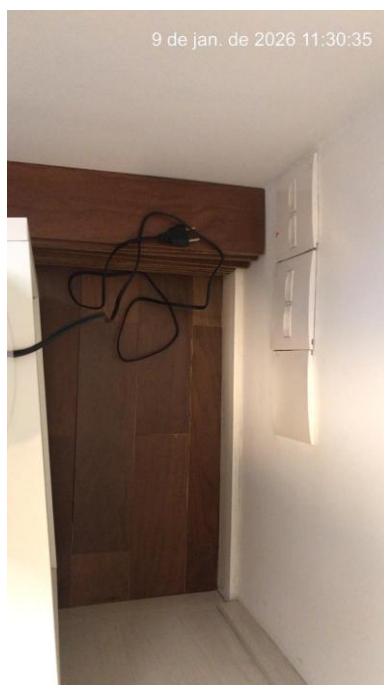
Figura 16 - Parede não apresenta sinais de umidade provenientes da fachada
