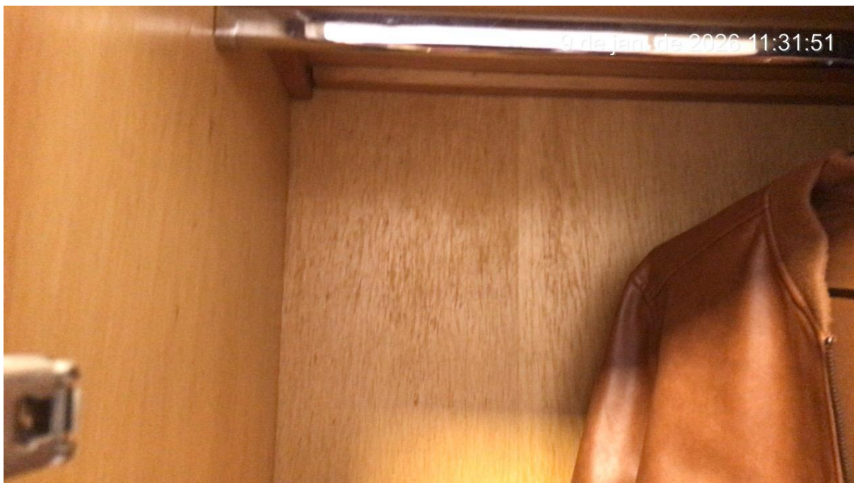
Figura 23 - Armário não apresenta sinais de umidade provenientes da fachada
