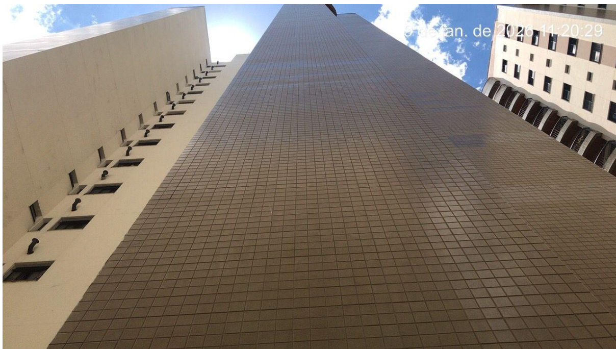
Figura 6 - Fachada a ser inspecionada
