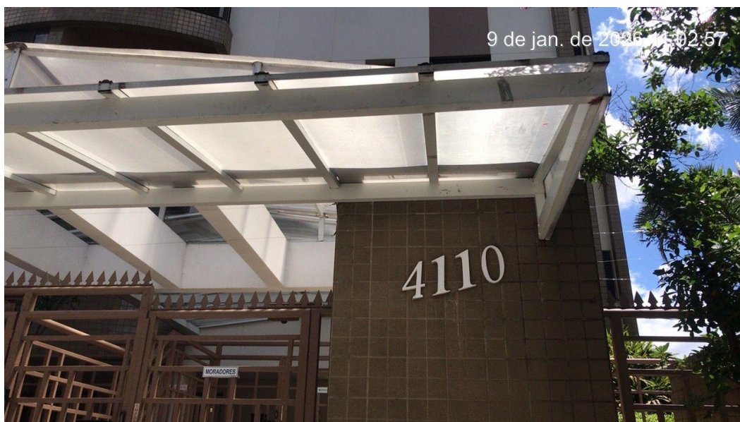
Figura 2 – Fachada e Número do condomínio
