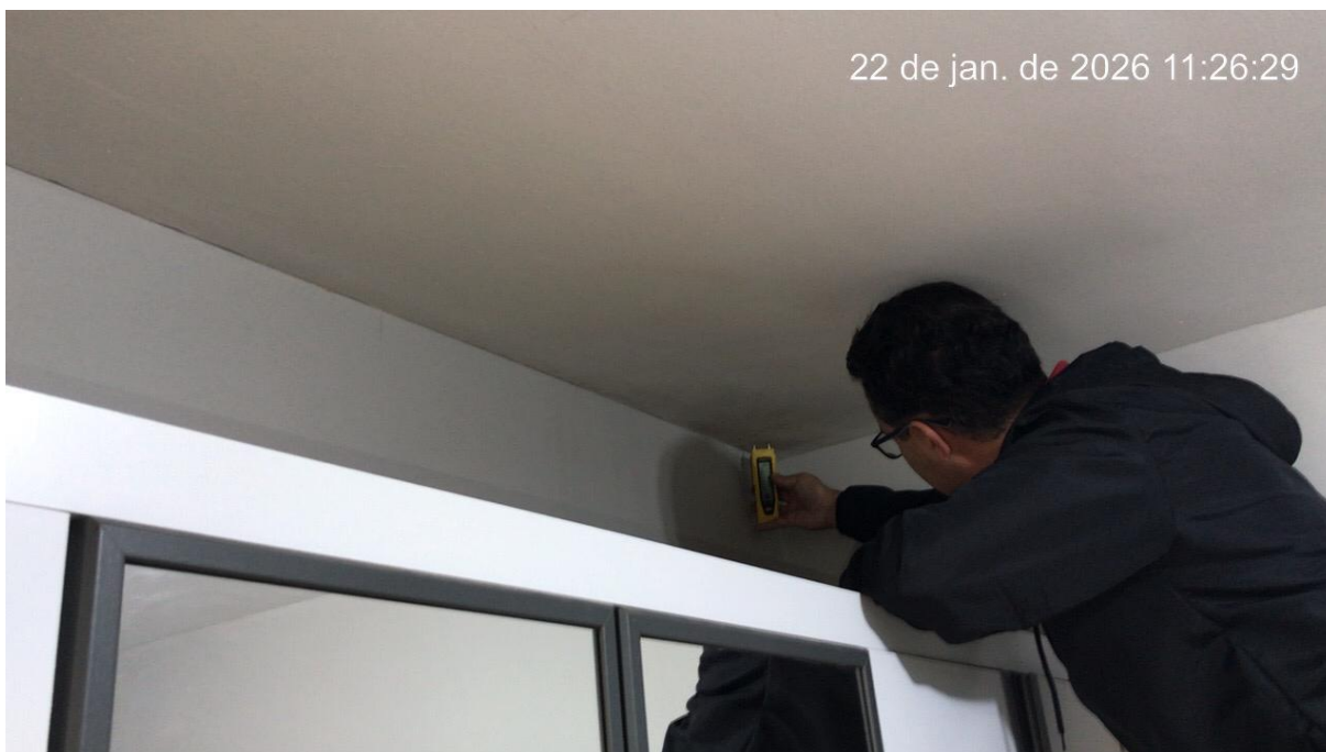
Figura 63 - Aferição de umidade realizada com medidor de umidade Stanley STH 77030
